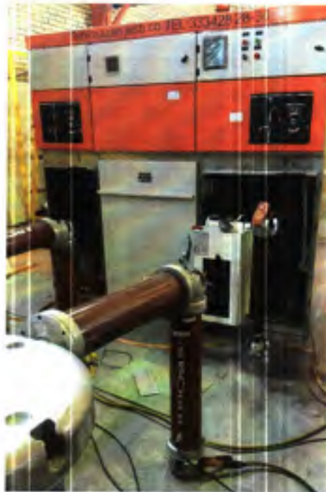
شکل ۱: تجهیز تحت آزمون ولتاژ قابل تحمل فرکانس قدرت
