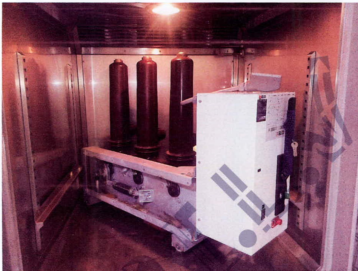
تصویر ۳: تجهیز بعد از تست رطوبت بر روی مدارات فرمان و کنترلی
